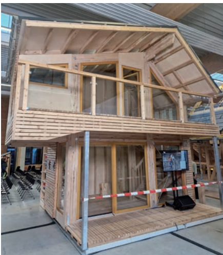
Abbildung 3: Zweigeschossiger Ausstellungsstand Birke im Zentrum Holz des Landesbetriebs Wald und Holz NRW in Olsberg
