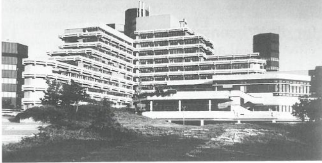
Das ingenieurwissenschaftliche Zentrum Köln-Deutz der Fachhochschule Köln
